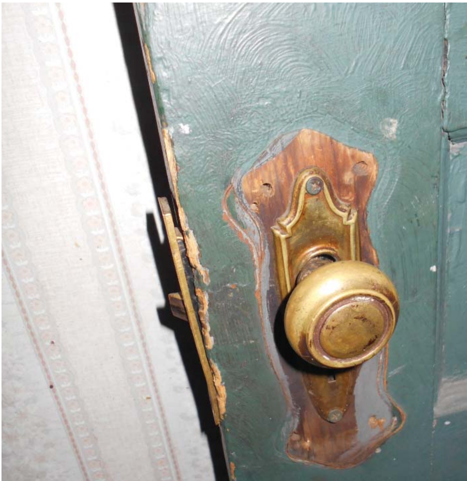
Photo 11 - Door missing hardware- broken door frame-
